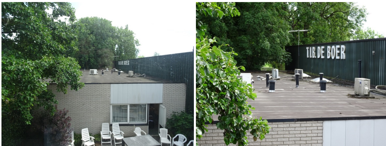
Figuur 12. Het platte dak uitgevoerd met alleen dakleer in de huidige situatie, is uitermate geschikt om te vormen naar kruidenrijk groendak met een vegetatie die bestaat uit sedumbegroeiing afgewisseld met veel en verschillende inheemse kruiden.
